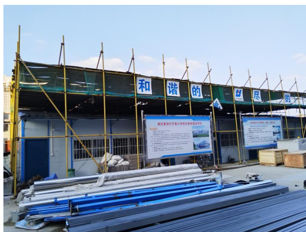
项目施工生产生活区现状（拍摄时间2024年11月）
