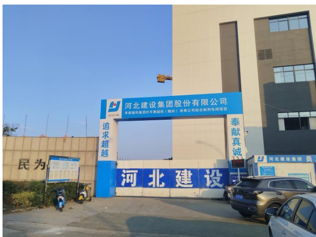
项目地块西侧入口处现状（拍摄时间2024年11月）
